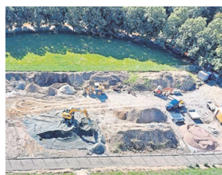
Renaturierung ehemalige Baustelleneinrichtung.
