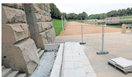
Bau barrierefreier Zugänge
