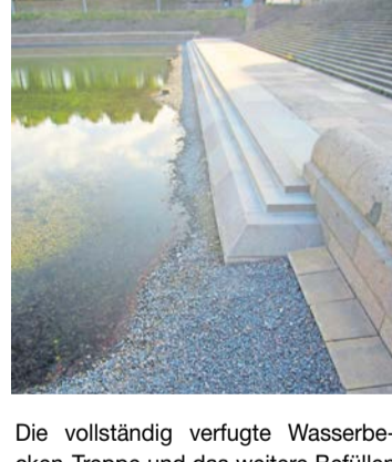
Die vollständig verfugte Wasserbecken-Treppe und das weitere Befüllen des Wasserbeckens.
