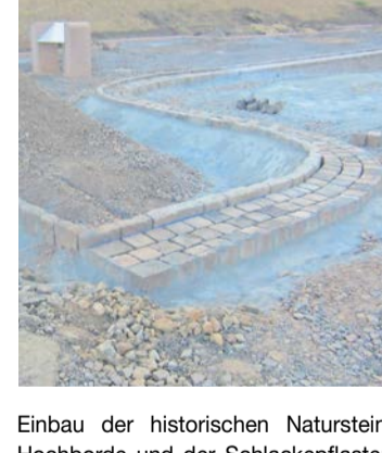
Einbau der historischen Naturstein-Hochborde und der Schlackepflasterrinne am Eingang zum Parkplatz.
