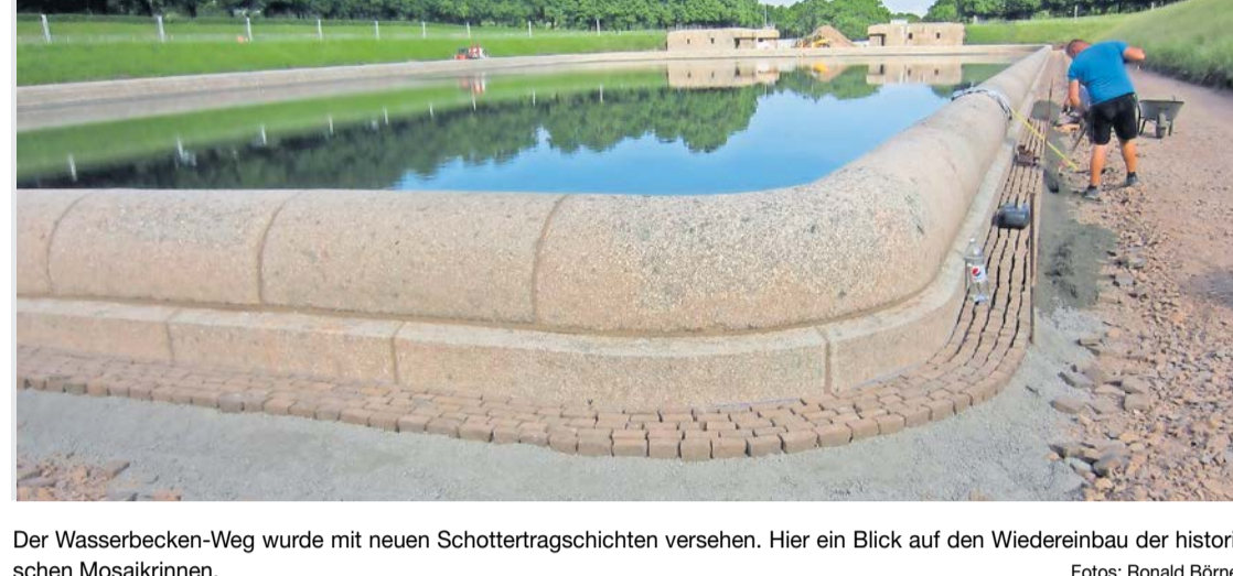
Der Wasserbecken-Weg wurde mit neuen Schottertragschichten versehen. Hier ein Blick auf den Wiedereinbau der historischen Mosaikrinnen.
