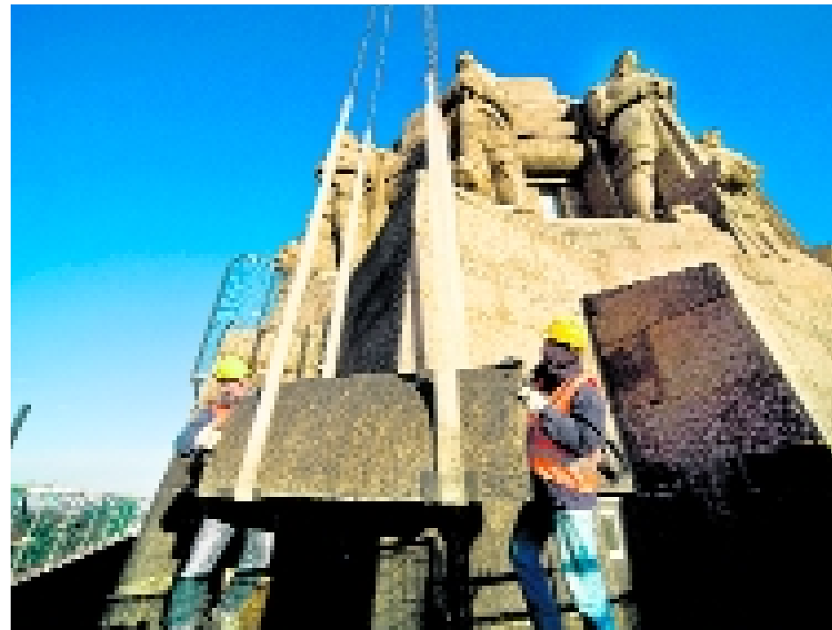
Bild rechts: Bei der Montage der Brüstung
