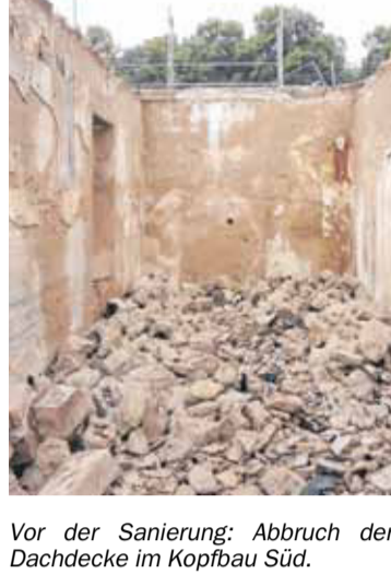
Vor der Sanierung: Abbruch der Dachdecke im Kopfbau Süd.
